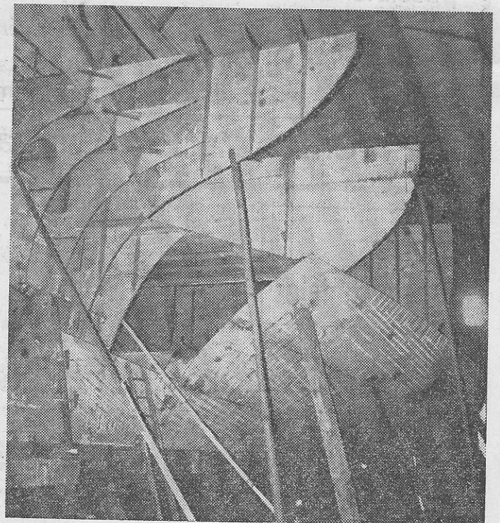
Dans la « cathédrale », l'ossature d'un puissant remorqueur pour Djibouti.
